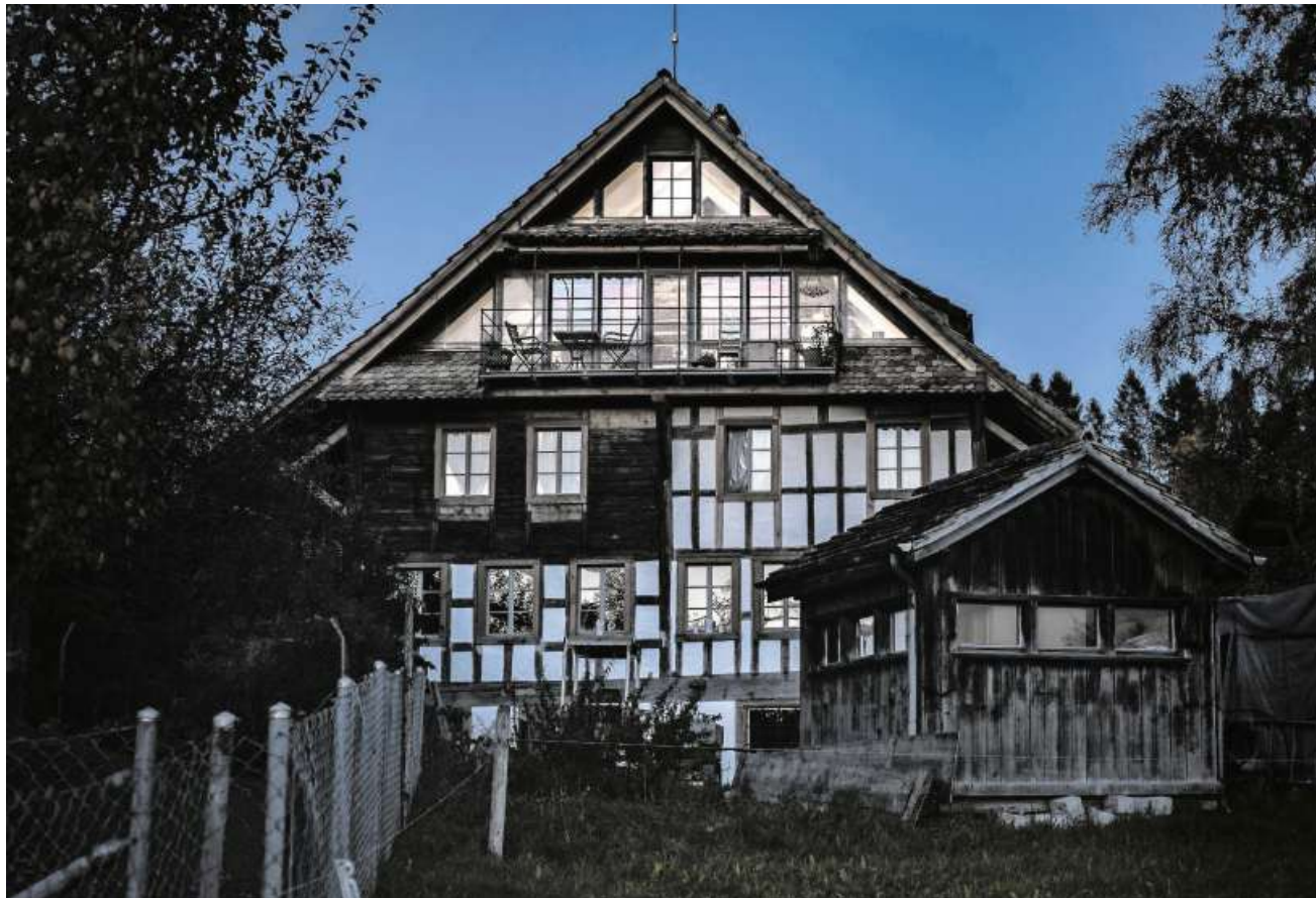
Um ins düstere Dachgeschoss viel Licht zu bringen, wurde der Giebel fast komplett verglast
