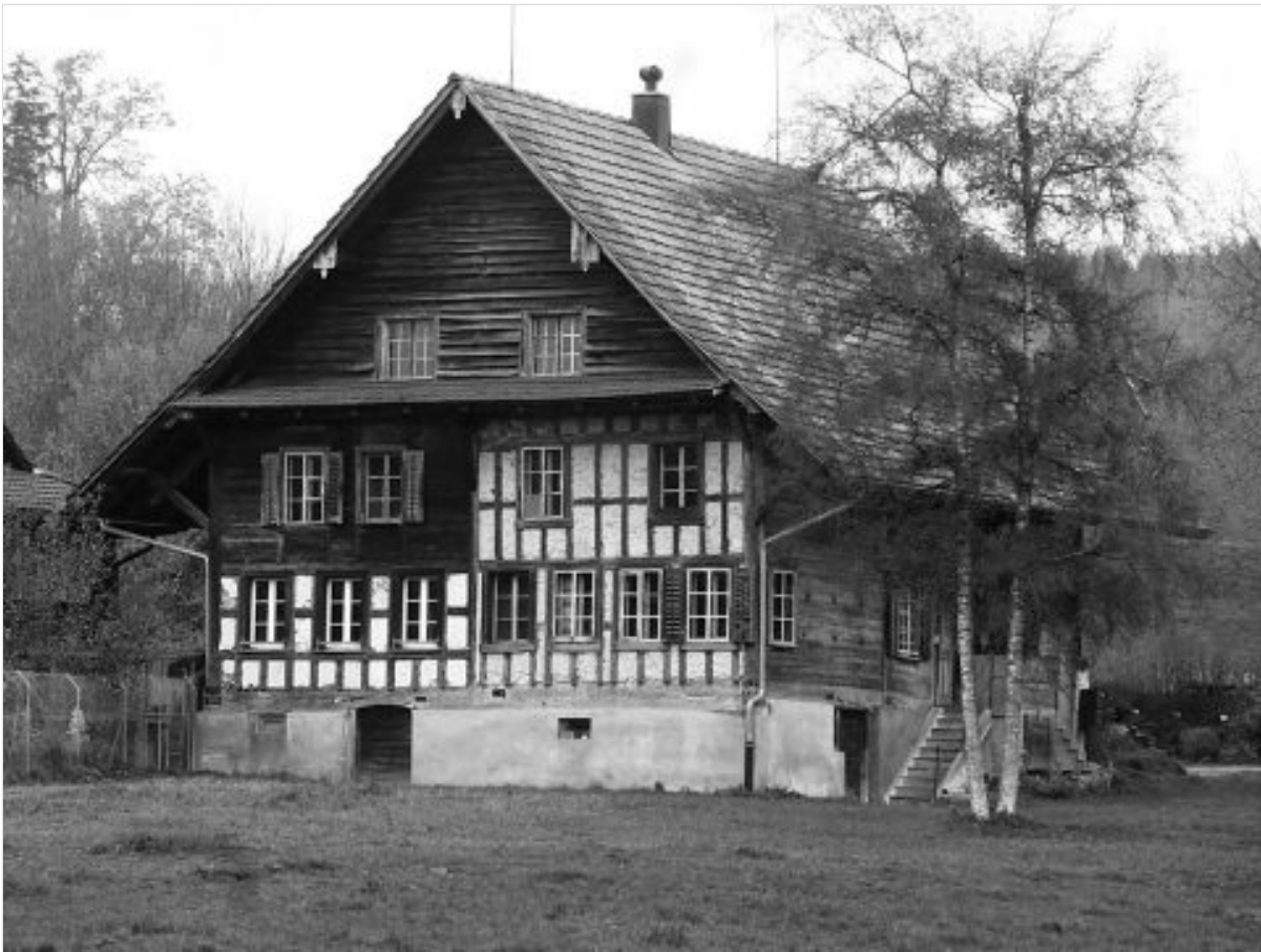
Das Haus ist im vorderen Teil ein Strickbau, wobei ein Teil der Fassade durch ein (einst günstigeres) Fachwerk ersetzt wurde.
