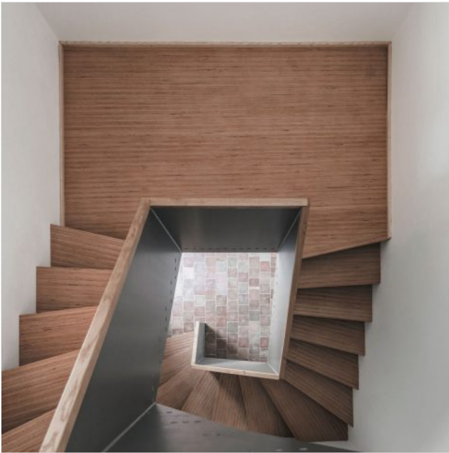
Die Dachwohnung wird durch ein eigenes Entree und eine eigene Treppe erschlossen. Die Stahlkonstruktion gehört zu den Highlights.
